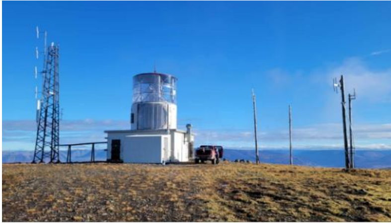
Stóðvarhúsið á Þrándarhlíðarfelli er í 920 m. hæð yfir sjávarmáli.
