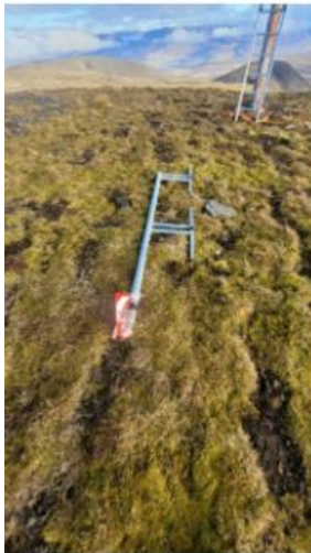
Kathrein 2-trípóla VHF loftnetið klárt til uppsetningar.
