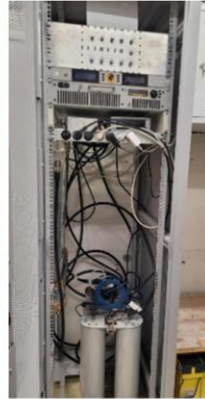
Nýi Icom endurvarpinn klár. „Cavity“ síurnar eru neðst.
