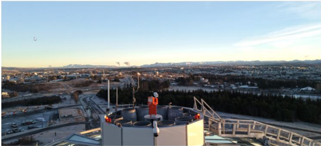
Lofnet nýja endurvarpars TF3RVK er fest efst á kúpuna á Perlunni í Öskjuhlíð. Frábært útsýni er þaðan til allra átta.
