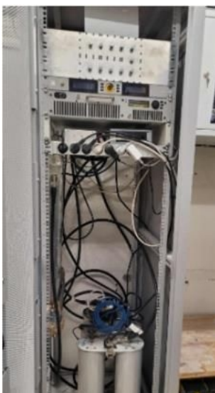
Nýi Icom endurvarpinn tengdur. „Cavity“ síurnar eru neðst.
