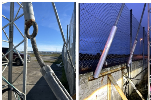
Myndirnar sýna bogna strekkjarann og síðan báða eftir lagfæringu. Ljósmyndir: TF2LL.
