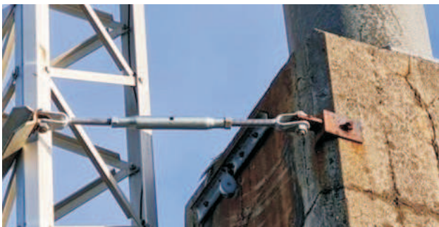
Seinni nýi strekkjarinn kominn upp. Ljósmynd: TF3CW.
