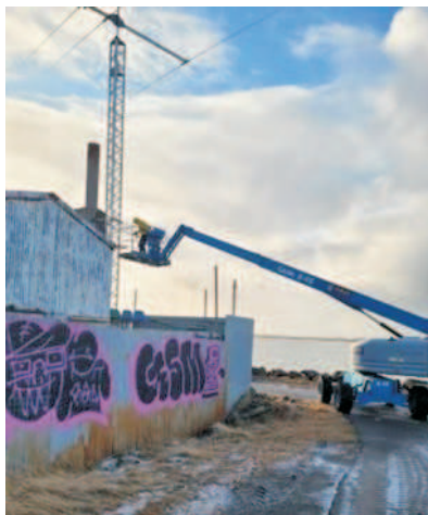
Unnið við strekkjara í Skeljanesi. Ljósmynd: TF3GMG.
