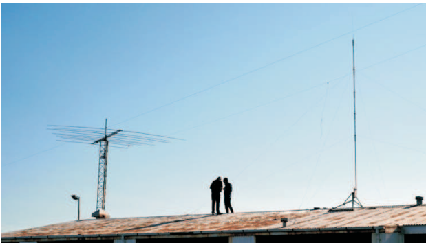
Þegar sett var upp nýtt New-Tronics Hustler 6BTV stangarloftnet fyrir TF3IRA í Skeljanesi sumarið 2023, voru lagðir út radíalar vegna þess hve ryðgað þakjárníð var.
