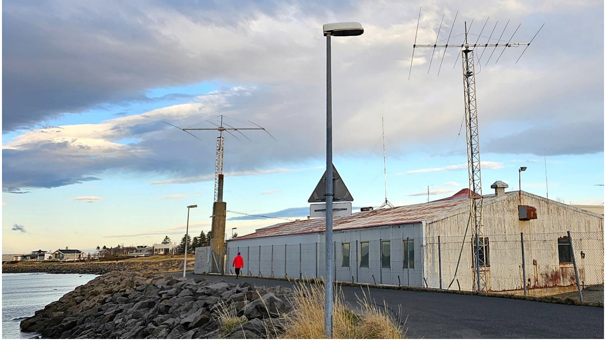
Ljósmynd af loftnetum félagsstöðvarinnar TF3IRA í Skeljanesi 5. nóvember 2023. Séð frá vinstri: OptiBeam OB4-20OWA 4 staka Yagi loftnet fyrir 14 MHz; NewTronics Hustler 6BTV stangarloftnet fyrir 3.5-7-10-14-21-28 MHz; og OptiBeam OBDYA9-4 9 staka Yagi loftnet fyrir 18-21-24-28 MHz. Í fjarska má greina fleiri loftnet félagsstöðvarinnar. Ljósmynd: Kristján Benediktsson TF3KB.
