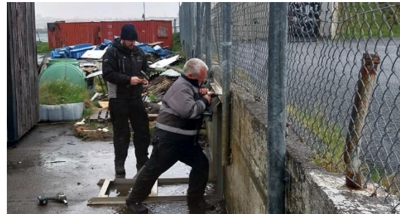
Borað fyrir stólnum í steinsteypta vegginn undir girðingunni.
