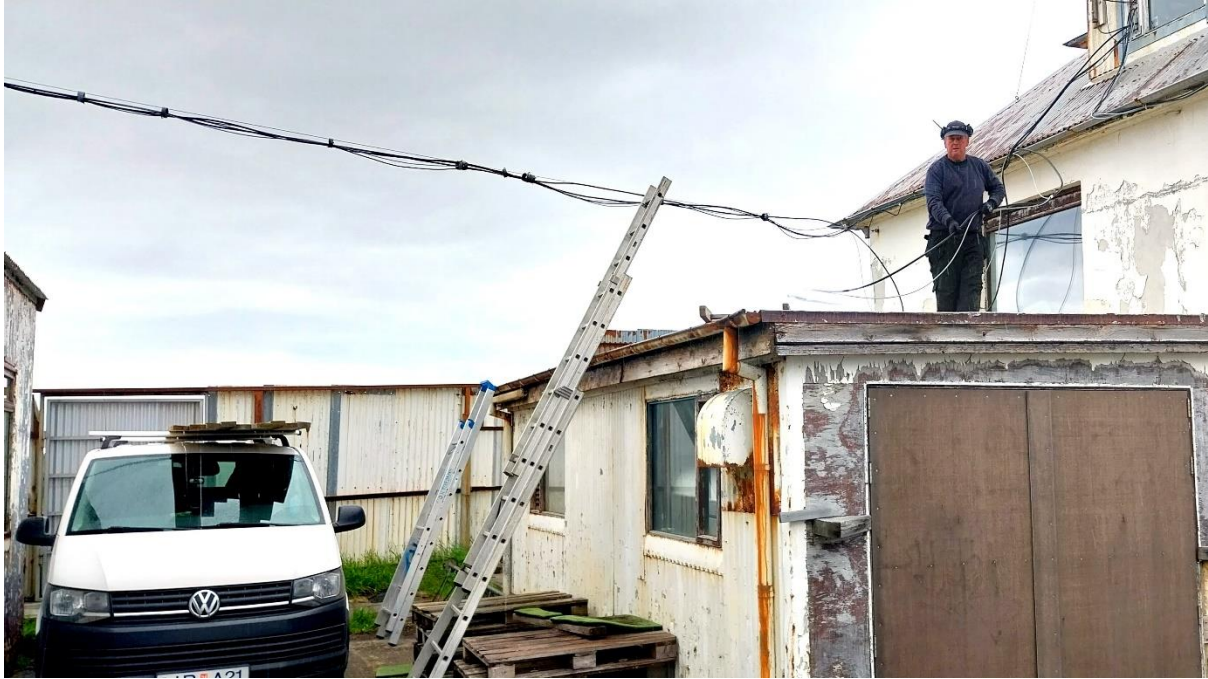
Georg er búinn að þræða flutningslínurnar í gegnum hringina á stálvírnum og skildi eftir slaka fyrir utan fjarskiptaherbergið.
