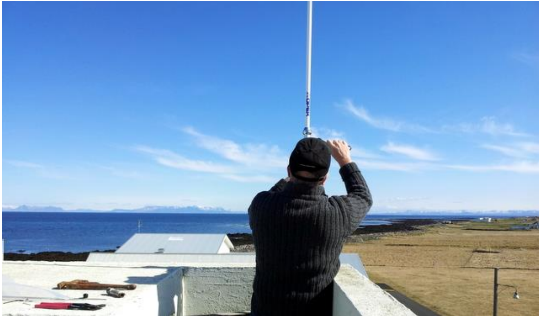
Garðskaga 21. apríl 2012. TF3ARI gengur frá uppsetningu OPEC UVS-300 VHF/UHF húsloftnetsins fyrir TF8RPH.
