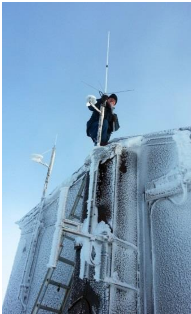
Jón Ingvar Óskarsson TF1JI gengur frá nýju Workman UVS-200 VHF/UHF húsluftneti fyrir TF1RPB.
