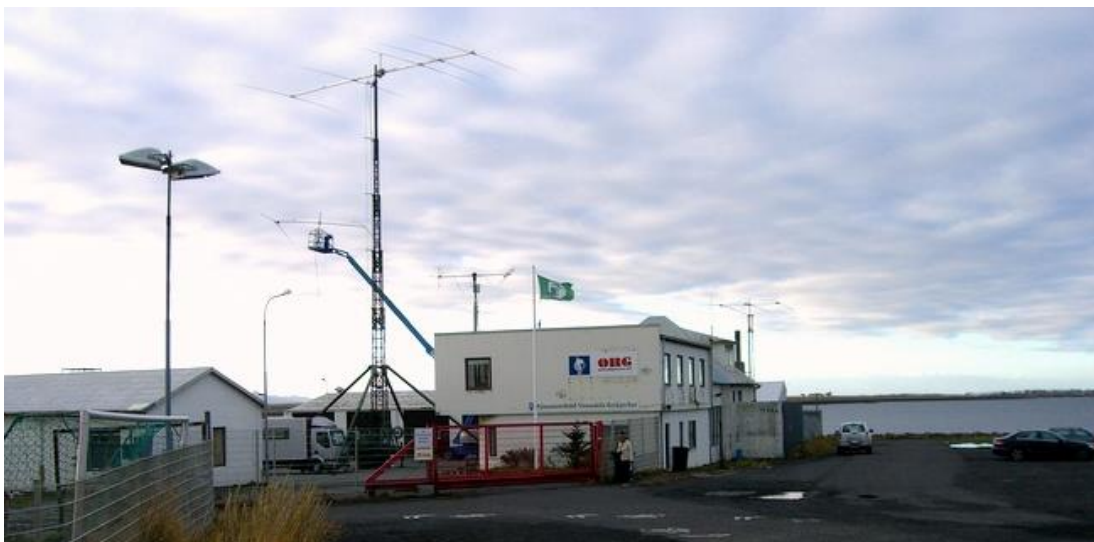
Loftnetin sem TF3W hafði til ráðstöfunar í SAC SSB keppninni 2012 voru, frá hægri til vinstri: SteppIR 3E 3 staka Yagi lofnet á 10, 15 og 20 metrum; Cushcraft 40-2CD einsbands Yagi loftnet á 40 metrum og OptiBeam OB-5 einsbands Yagi loftnet á 20 metrum.
