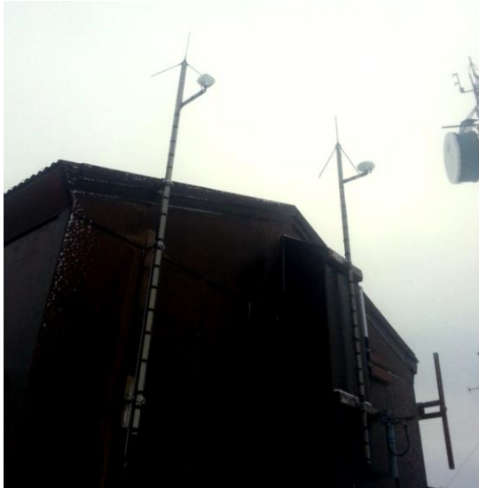
¼-bylgju GP loftnetið sem félagið fékk lánað er staðsett hægra megin á þaki stöðvarhússins.
