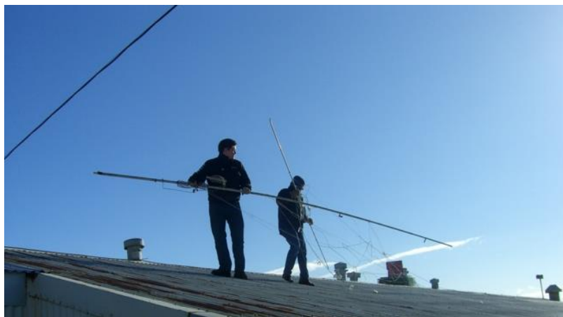
Butternut HF6V tekið niður til viðgerðar 24. mars. Benedikt Guðnason TF3TNT og Erling Guðnason TF3EE hjálpast að við flutninginn.
