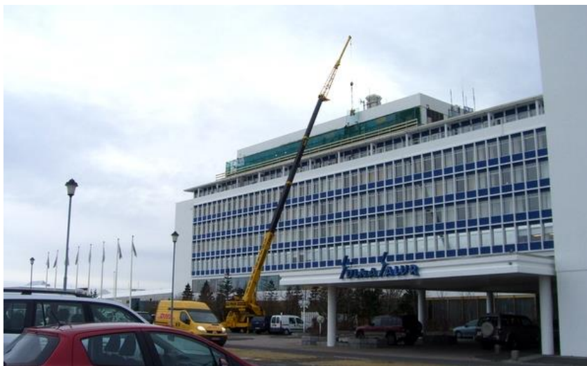
Mynd frá byggingaframkvæmdum við Radisson Blu Hótel Sögu í Reykjavík í febrúar 2013.
