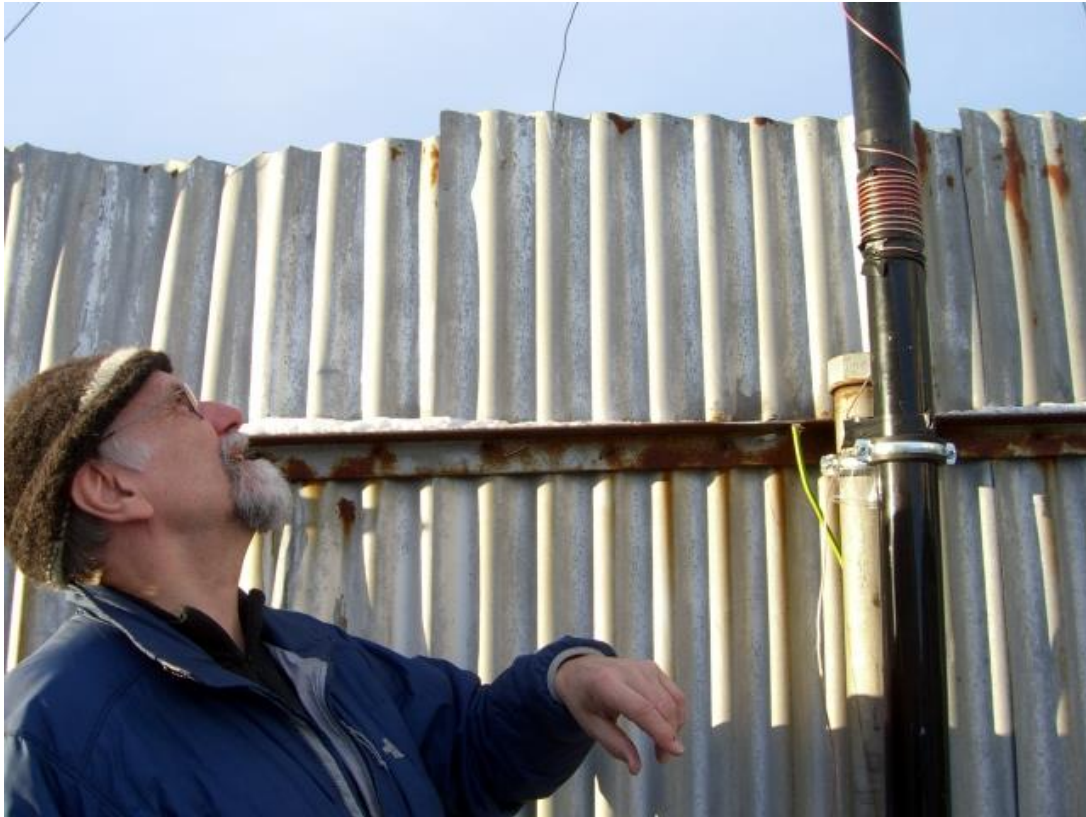
Vilhjálmur Þór Kjartansson TF3DX horfir upp eftir 18 metra hárra glertréfastönginni frá Spiderbeam. Vilhjálmur hannaði aðlögun kóax fæðilínunar við „L“ loftnetið „á hvolfi“ á 160 metrum. Þessi vinna fór fram þann 17. febrúar. Ljósmynd: TF2JB.
