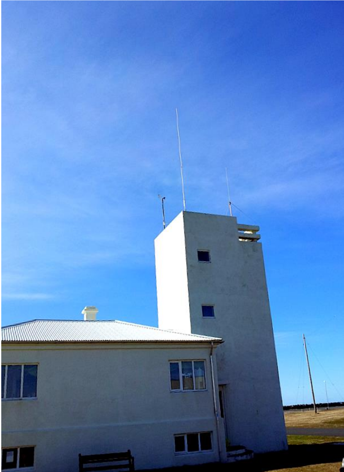
Afstöðumynd. Loftnet TF8RPH er staðsett á turninum við vitavarðarhúsið. Ljósmynd: TF8SM.
