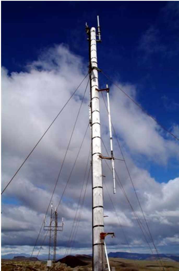
New-Tronics G6-144B Loftnet TF1RPB á burðarstaurnum sem brotnaði í október 2011. Loftnetið gefur 6 dB ávinning yfir tvíþól. Ljósmynd: Sigurður Harðarson TF3WS.
