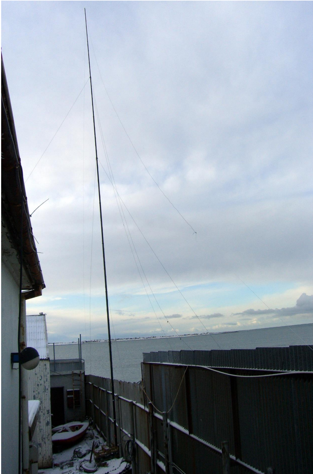
Myndin er af 18 metra hárrí glerfíberstöng frá Spiderbeam sem notuð var fyrir TF3W sem „L“ loftnet á hvolfi á 160 metrum í ARRL DX morsképpninni 18.-19. febrúar. Á bls. 29 í skýrslunni má sjá nærmynd af fæðingu loftnetsins og hvernig það var fest við bárujárnsvegginn. Ljósmynd: Jónas Bjarnson, TF2JB.
