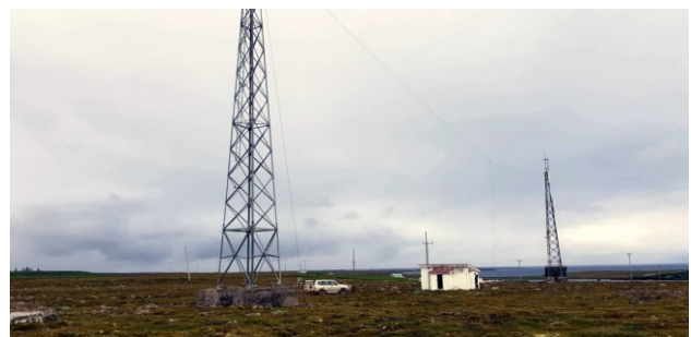
Á myndinni má sjá turnana sem halda uppi lóðrétta T-loftmetinu sem er tengt við KiwiSDR viðtækið og er staðsett í skúrnum hægra megin við bifreiðina. Ljósmynd: TF3GZ.
