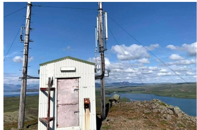
Þessi skúr er á Úlfjótssfjalli, í 248 m. hæð yfir sjávarmáli. Hann hýsir APRS búnað TF1SS-1. Staðsetning er með útsýni er til allra átta. Ljósmynd: Guðmundur Sigurðsson TF3GS.
