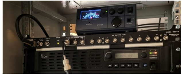
TF1RPB VHF FM endurvarpinn í Bláfjöllum. Ljósmynd: Ari Þórólfur Jóhannesson TF1A.
