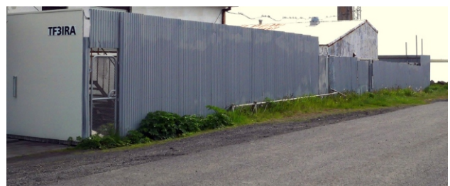
Skeljanesi 9.6. Verkefninu lokið. Mun snyrtilegra að lita yfir vegginn. Ljósmyndir: TF3JB.
