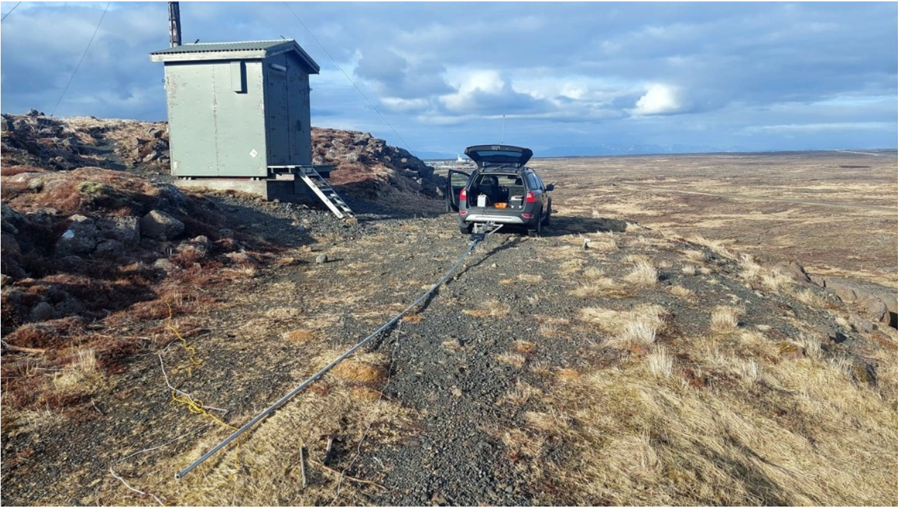
TF8KY 17/4. Stangarloftmetið fyrir 80 metrana lagt út áður en það var reist. Ljósmynd: TF8KY.
