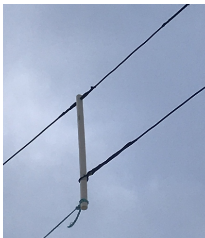
Mynd 3.a. Sjá má hvar 80 metra armurinn kemur í gegn um „spreaderinn“ og 40 metra armurinn endar. Þarna sést líka hvernig smá virbútur er lagður upp til þess að eiga möguleika á lengingu ef með þarf.
