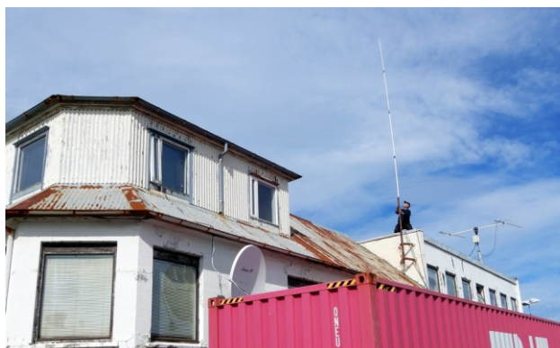
Diamond X-700HN VHF/UHF loftnet TF3IRA var sett upp 16. ágúst í sumar. Það var Geoerg Kulp TF3GZ sem annaðist uppsetningu og frágang. Ljósmynd: TF3JB.
