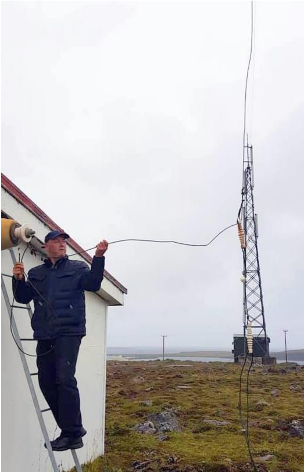
10. ágúst á Raufarhöfn. Geog Kulp TF3GZ matar fæðinguna á loftnetinu við postulinseinangrarann á skúrnum sem hýsir KiwiSDR viðtækið. Viðtækið hefur afnot af T-loftneti, sem er lóðréttur vir (topplóðaður) og var fyrir á staðnum. Geog stóð að uppsetningu tækisins ásamt Árna Helgasyni, TF4AH, auk þess sem Ari Þórólfur Jóhannesson, TF1A, veitti tæknilega aðstoð. Ljósmynd: Árni Helgason, TF4AH.
