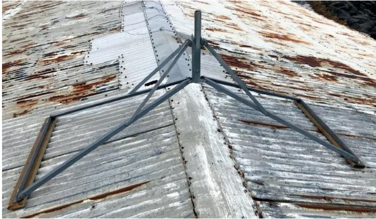
Loftnetsfestingin er sterkbyggð og sandblásin og zinkhúðuð. Auðvelt er að fella loftnetið þegar vinna þarf við það. Ljósmyndir: Georg Magnússon TF2LL.
