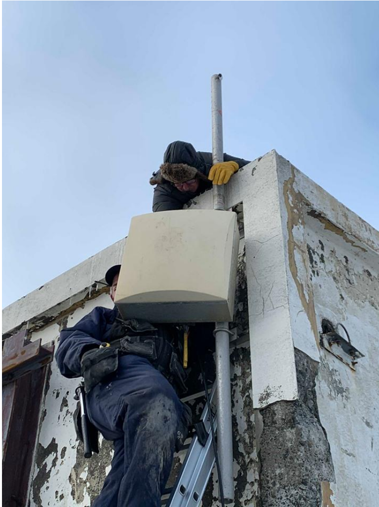
TF3GZ og TF3DT setja upp Katherein loftnet fyrir 430 MHz hlekkinn. Mynd: TF1A.
