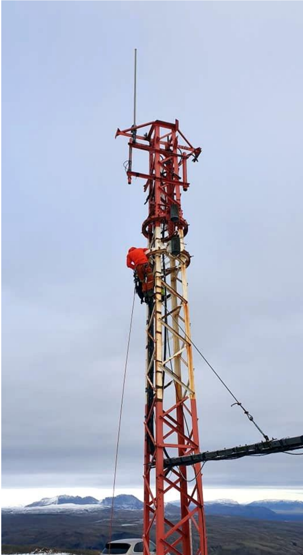
TF3SUT á leið niður úr turninum eftir uppsetningu nýja Diamond SE-300 loftnetsins. Ljósmynd: TF1A.
