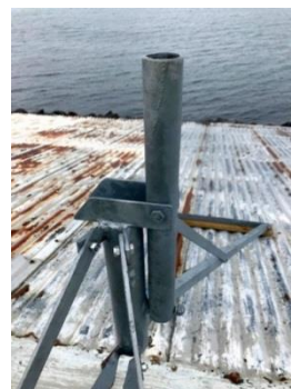
Loftnetsfestingin er sterkbyggð, sandblásin og zinkhúðuð. Auðvelt er að fella loftnetið þegar vinna þarf við það, aðeins að losa einn bolta. Ljósmyndir: Georg Magnússon TF2LL.
