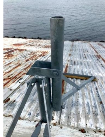
Aðeins þarf að losa einn bolta til að fella loftnetið.
