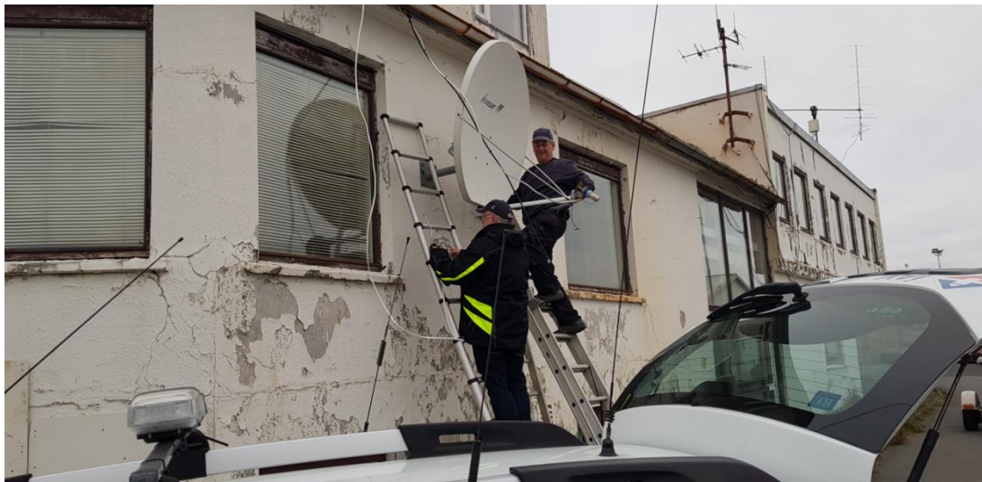
1. október. Nýr 120cm diskur kominn á veggfestinguna og unnið að stillingum. Ari Þórólfur Jóhannesson TF1A og Georg Kulp TF3GZ. Ljósmynd: Óskar Sverrisson TF3DC.
