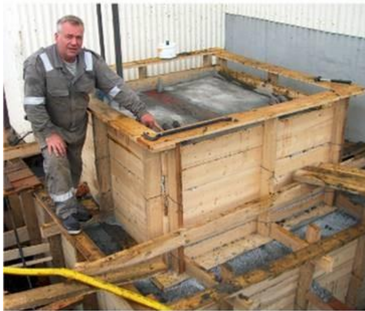
Þarna sést té bitinn sem lagður var í steypuna.
