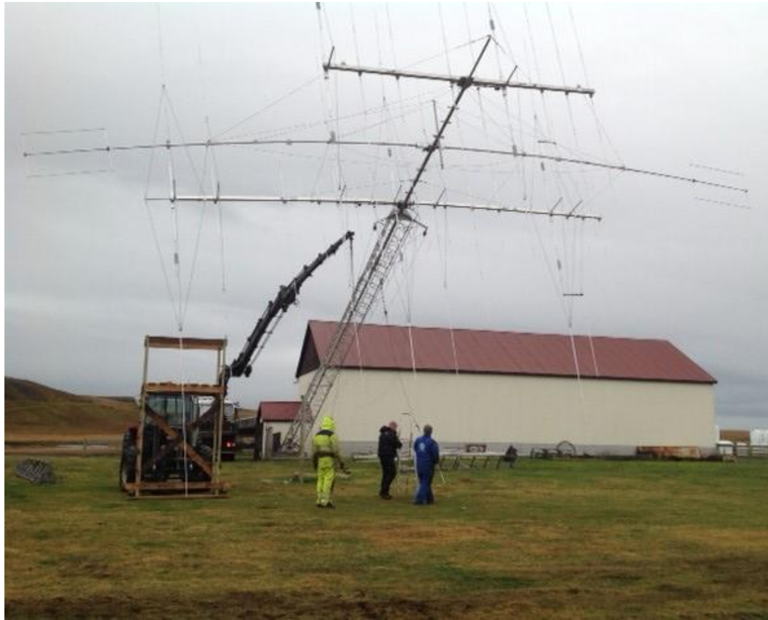
Þarna er verið að byrja ða reisa turninn, búið að lyfta í talsverða hæð og verið að stinga restinni af elementunum á bás.
