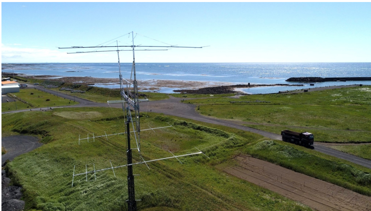
H-ramminn sem heldur 6 elementa einsbands Yagi loftnetunum fjórum í réttri fjarlægð innbyrðis er mjög öflugur. Hér sést hann í endanlegri gerð, en Ólafur þurfti að prófa sig áfram með stögunina, sem er mjög öflug og byggist í grunninn á 16 stálvírum. Ljósmynd: TF1A.
