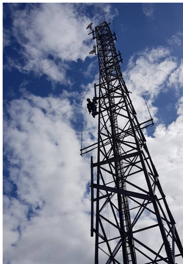
Vinna við uppsetningu loftneta fyrir TF1VHF. Greina má TF3SUT uppi í turninum. Ljósmynd: TF1A.
