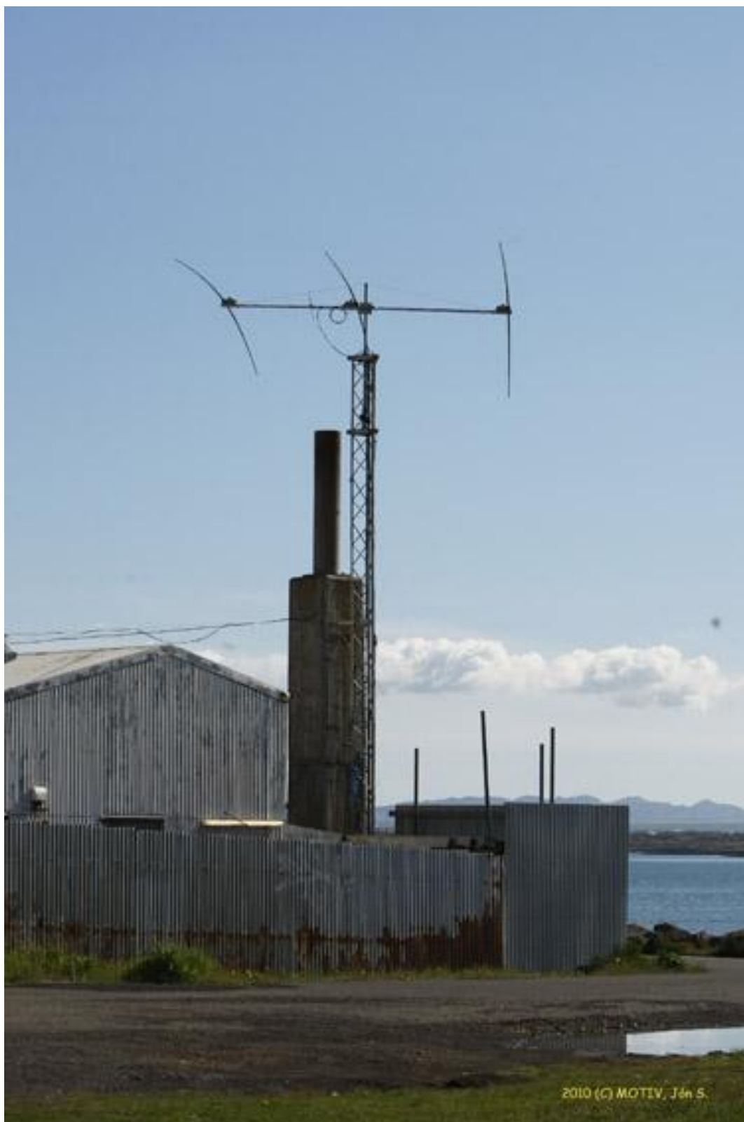
SteppIR 3E 3 staka Yagi loftnet TF3IRA við félagsaðstöðu Í.R.A. í Skeljanesi. Ljósmynd: Jón Svavarsson, TF3LMN.
