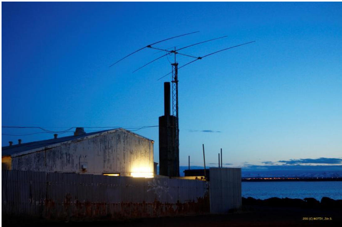
SteppIR 3E 3 staka Yagi loftnet TF3IRA. Myndin er tekin á Porra í 13. viku vetrar 2011. Ljósmynd: Jón Svavarsson, TF3LMN
